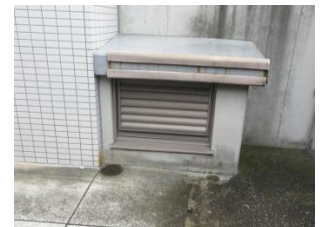
⑦-1&2 地下室換気口
