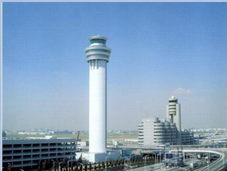
羽田国際空港の管制塔 新(左) & 旧(右: 当時)
