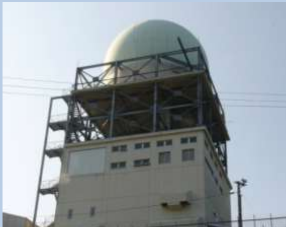
航空路監視レーダー (ARSR+SSR)
