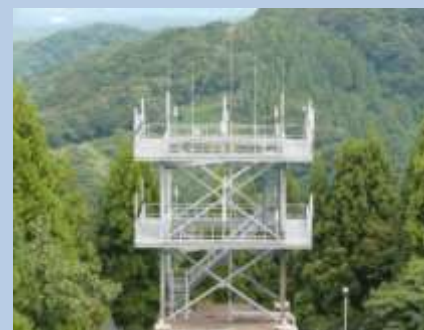
遠隔無線通信施設 (RCAG)
