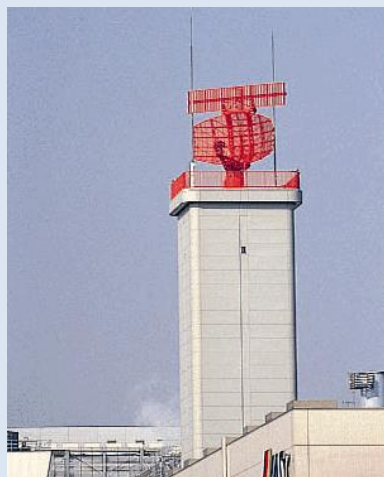
空港監視レーダー (ASR+SSR)
