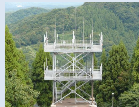
遠隔無線通信施設(RCAG)
