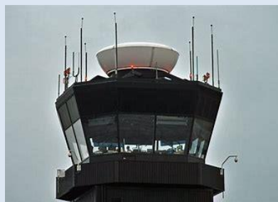
管制塔の外観 屋上: 場面監視レーダー (ASDE)
